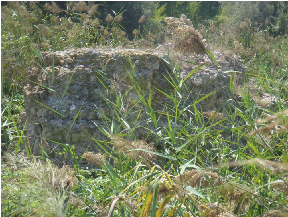
Vista en detalle de Las Pilastras
